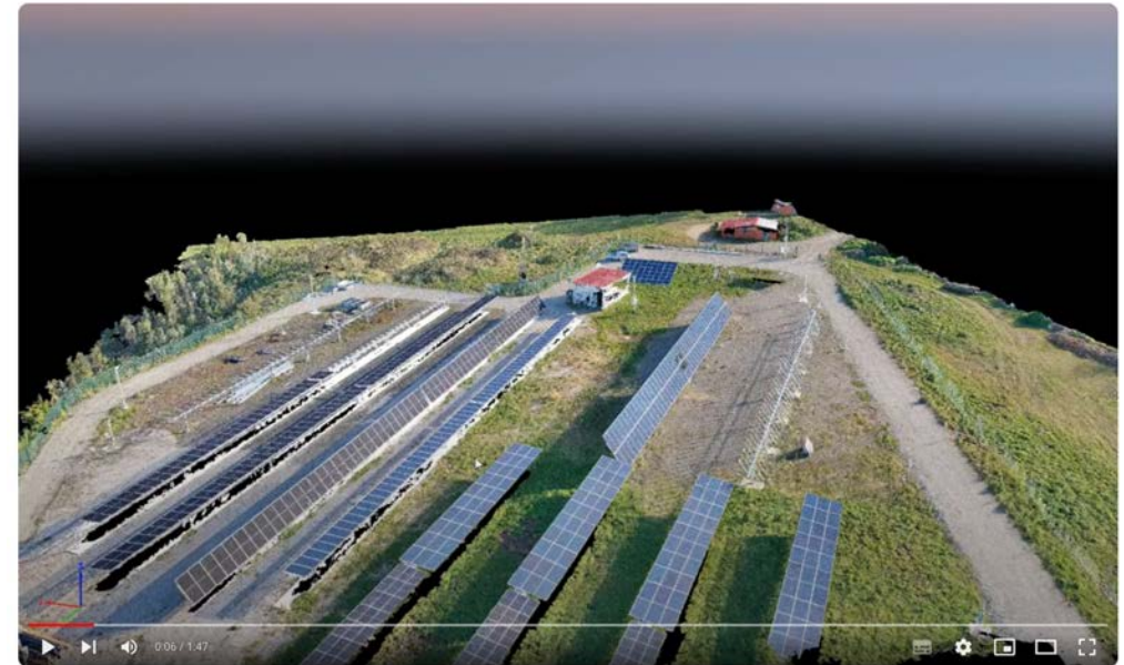
Vista 3D Nube de Puntos Parque Fotovoltaico
